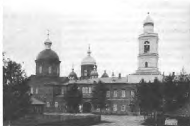
Леушинский монастырь. Слева направо: Троицкий собор (№12 на плане). За ним видны купола Похвальского собора (№10 на плане); чуть правее – купол домово́й церкви при богадельне (№ 13 на плане) и надвратная колокольня (№ 13 на плане).
