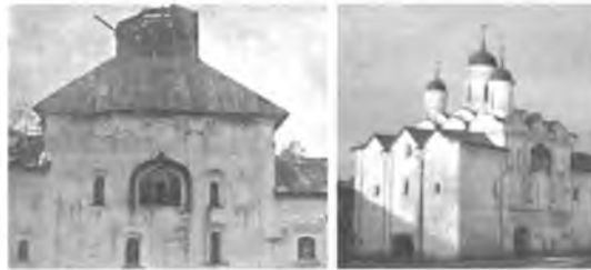
Преображенский собор Кирилло-Белозерского монастыря. Слева: вид храма в 1930-е годы; справа: современный вид отреставрированного храма
