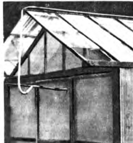
Рис. 1. Система для охлаждения воздуха в теплице
