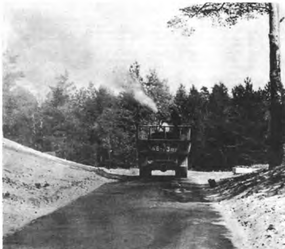
Гидропосев газонных трав на откосах
