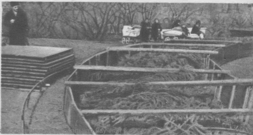
Вид укрытия со снятыми потолочными щитами
