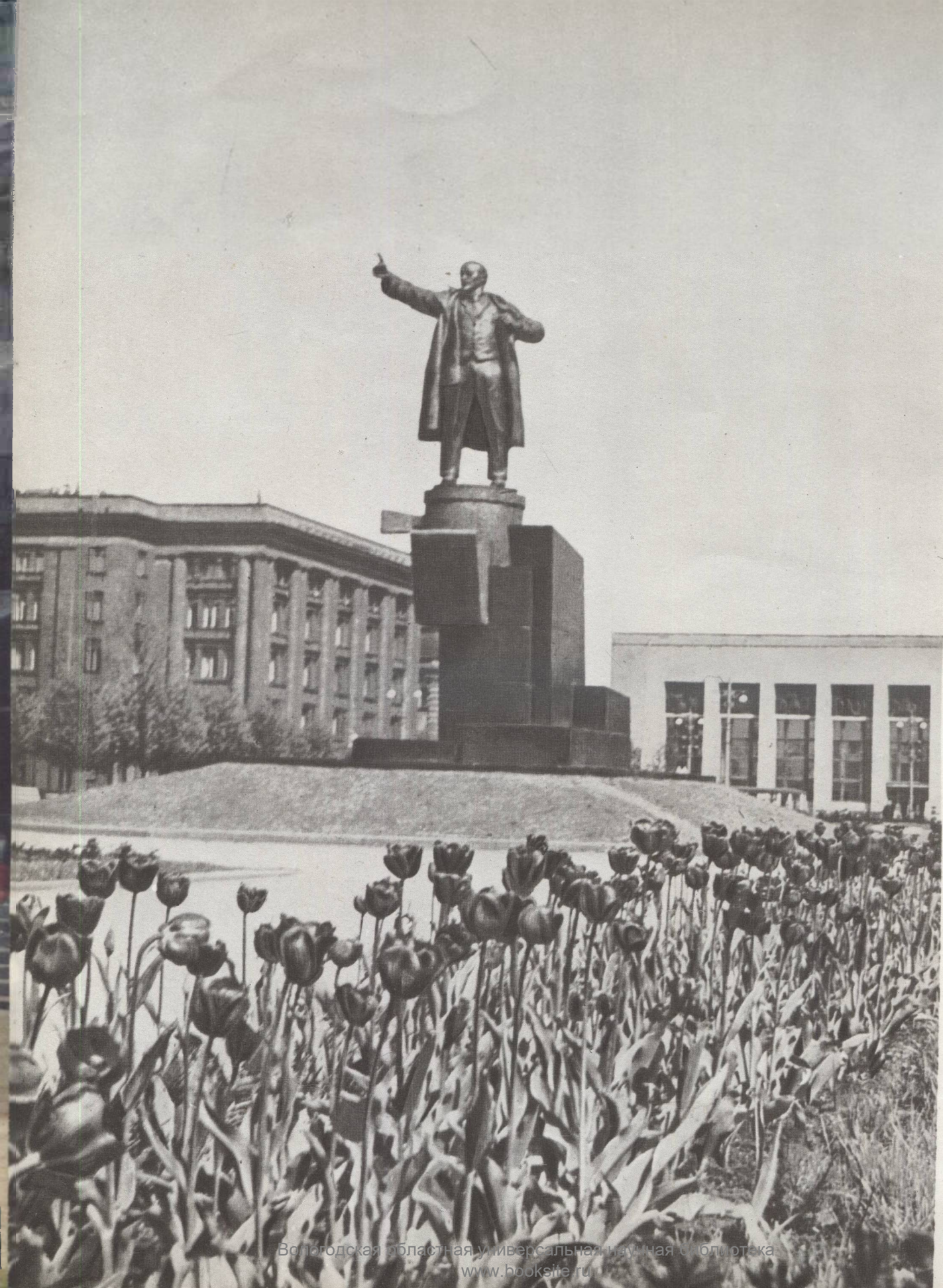
Ленинград. На площади у Финляндско- вокзала.
