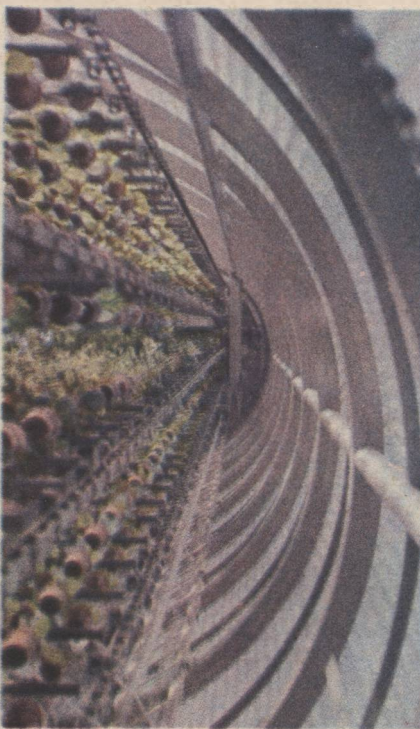
Внутренний вид башенной теплицы (сфотографировано снизу вверх)
