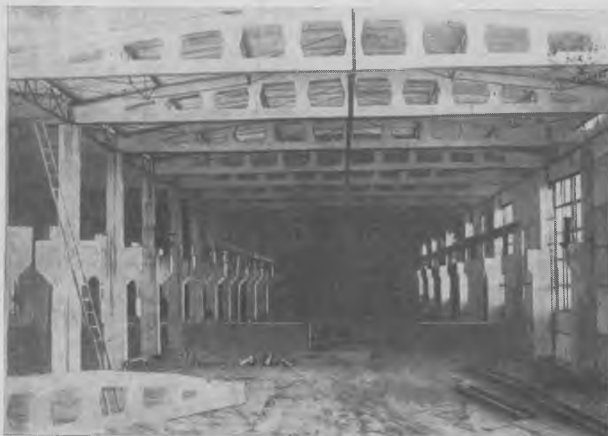
Рис. 4. Строительство текстильного комбината с применением арочных решетчатых балок
