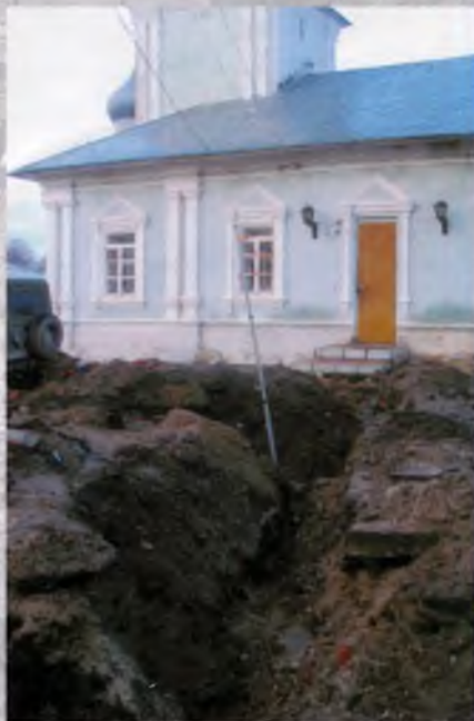
Траншея возле церкви Александра Невского
