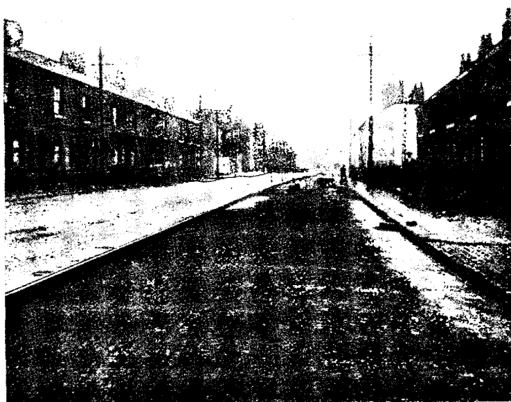
Желѣзобетонное основаніе для улицы въ Манчестерѣ.
