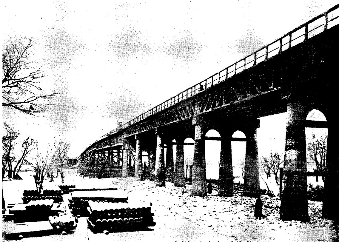
Желѣзобетонная часть Черниговскаго моста со стороны Киева.
