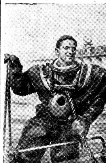
На строительстве Чимлянского гидроузла. Водолаз комсомолец Георгий Скабун перед спуском в воду для обследования донных отверстий.
