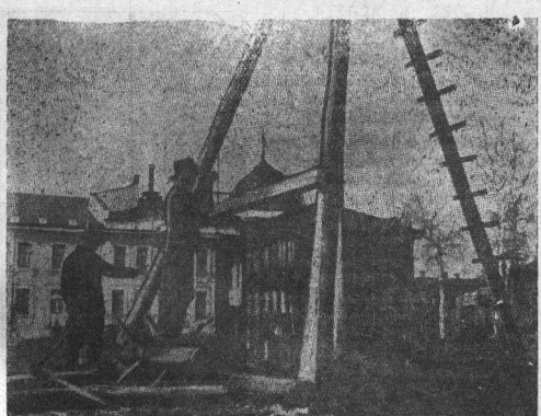
Подготовка к строительству здания управления Северной дороги. На снимке: монтаж устонов для исследования в чуда на территории клуба им. Октябрьской революции. Фото П. Брызгалова.
