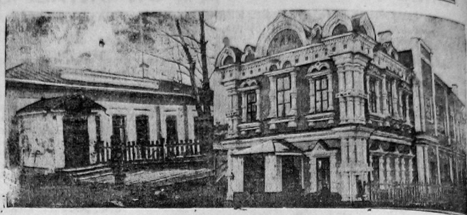
На снимках — новое здание Вологодского радио-узла (справа). Вновь переоборудованный и открытый рваный клуб печатников и металлостроителей
