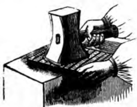
Колотильный молотокъ для колоченія книгъ, и камень , на которомъ производится ихъ уколачиваніе.
