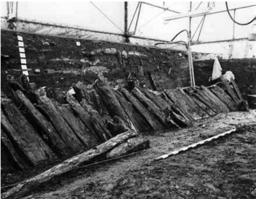
Рис. 7. Деревянные конструкции, окаймляющие причал в гавани Шлезвига
