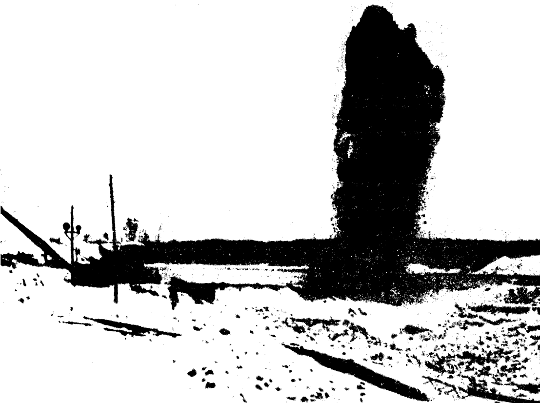
Взрыв перемычки котлована Череповецкого гидроузла в день перекрытия Шексны.
