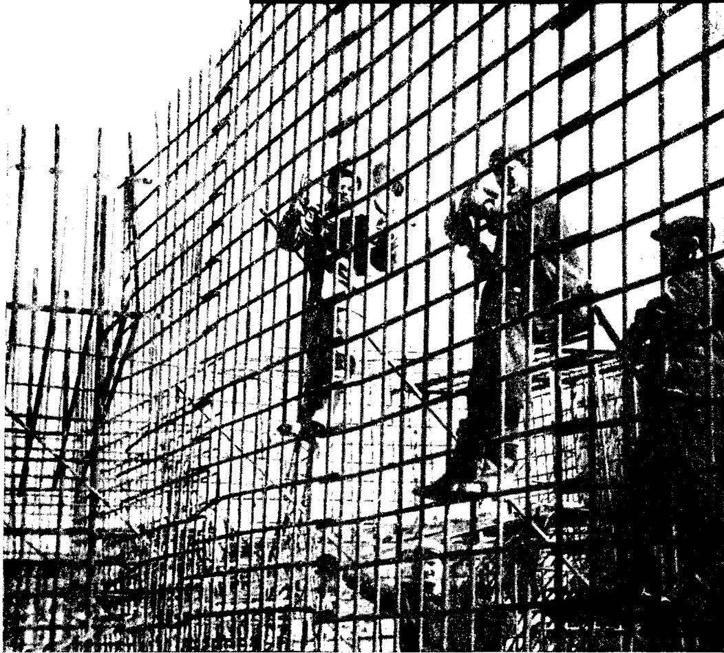
Арматурщики и электросварщики из бригады коммунистического труда А. И. Шоницева возводят арматуру на Череповецком гидроузле.
