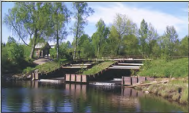
Современный вид Ковжской плотины
