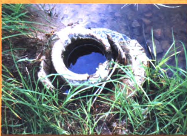
Устье соляной скважины
