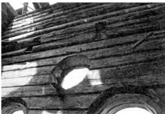
Ил. 8. Северная стена четверика. Вид изнутри. Фотография автора. 2009
