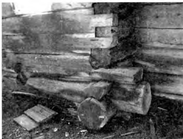
Ил. 5. Угол стыка главного сруба и алтарной апсиды. Фотография автора. 2009
