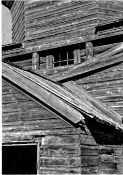
Ил. 5. Троицкая церковь. Зондаж западной стены притвора. Фотография автора. 1995. За обшивкой видна конструкция первоначального косячатого окна
