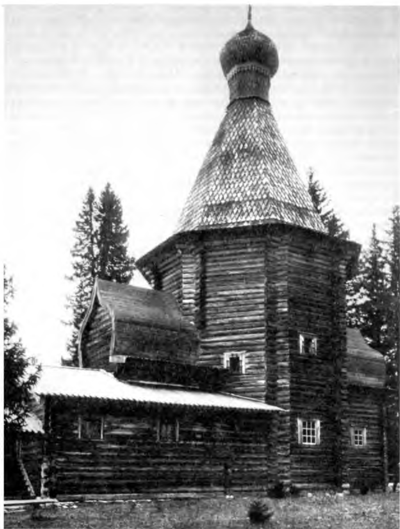
Ил. 1. Никольская церковь в селе Панилово после реставрации 1907–1908 гг. Фотография нач. XX в.
