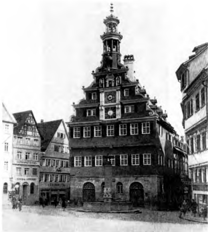
Ил. 12. Северный фасад после реконструкции
