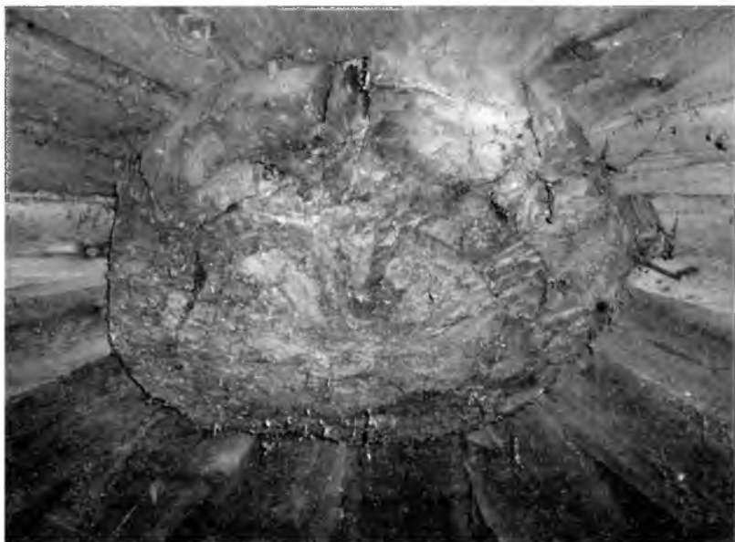
Ил. 4. Троицкая церковь. «Замок» каркасной конструкции потолка-«неба». Вид снизу. Фото В. П. Дренина. 2007
