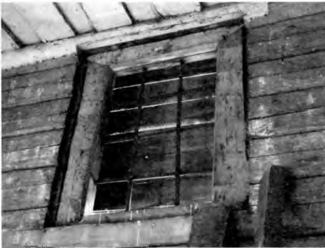
Ил. 6. Троицкая церковь. Западное косячатое окно притвора. Вид в интерьере. Фотография А. В. Никитина. 2005
