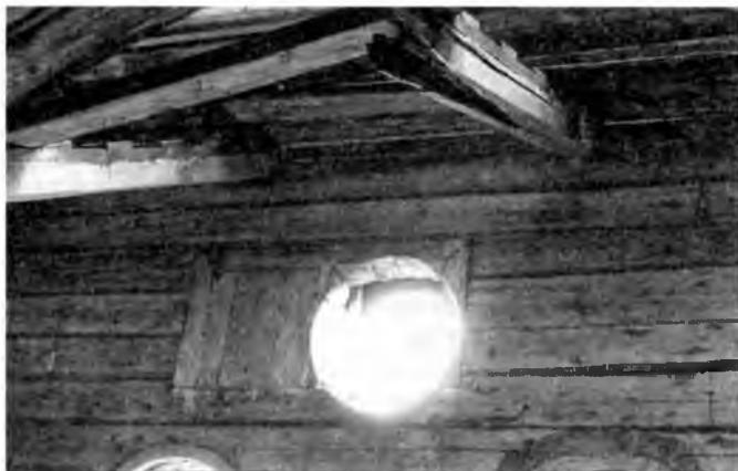
Ил. 7. Старое косячатое окно второго света в южной стене четверика. Фотография автора. 2009
