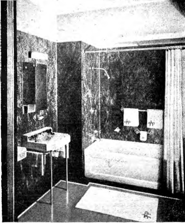
Рис. 72. Встроенная в нишу ванна с цельноотлитым бортом-фартуком. Умывальник имеет спинку в виде полочки, на которую ставятся туалетные принадлежности. Металлические ножки умывальника соединены с горизонтальными штангами-вешалками для полотенец. Стены, как и пол, покрыты тонким стеновым линолеумом
