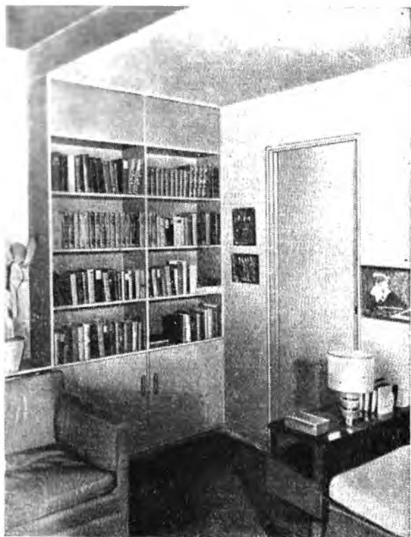
Рис. 35. Встроенный книжный шкаф в жилой комнате. В нижней докольной его части помещаются комплекты журналов и газет, в верхней части — фотопринадлежности и рабочий инструмент
