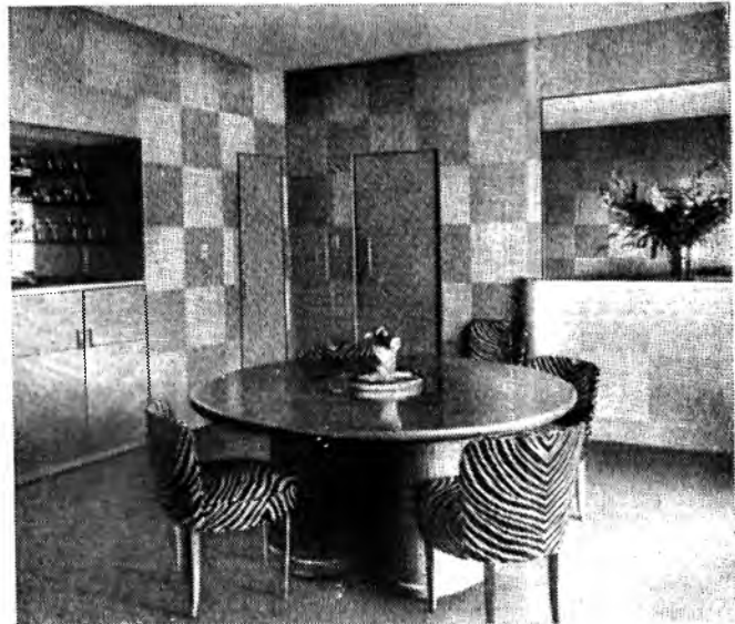
Рис. 43. Встроенные буфеты в столовой. Стены отделаны „флексвуд“ — новым отделочным материалом (ножевой фанерой, наклеенной на полотно)
