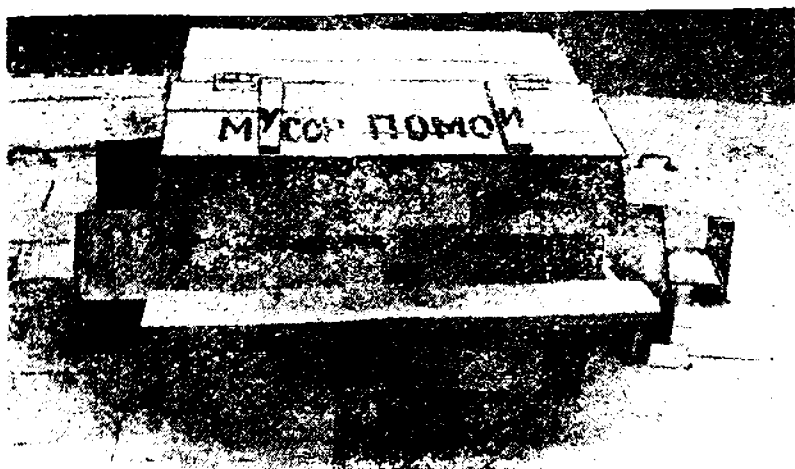
Рис. 27. Вид приемника для мусора и помоев над биотермическими камерами и бочкой-отстойником под общей крышкой с педальным самозатвором.
