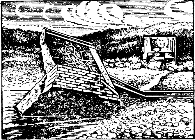
Фиг. 3. Устой, опрокинувшийся в сторону отверстия моста.
