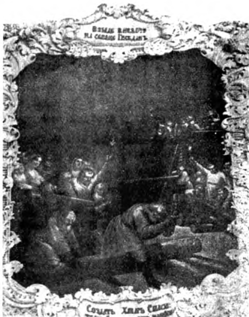
Строительство обыденного храма. Роспись в храме
