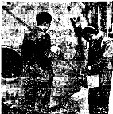
Измерительный прибор удерживается лямкой, оставляя обе руки свободными для измерений
