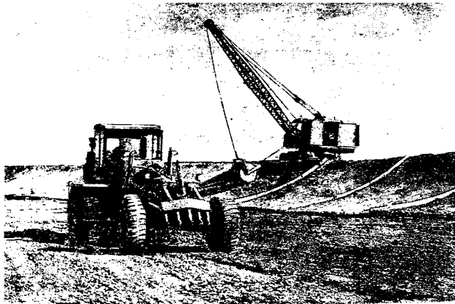
Уплотнение основания с использованием 10-тонного катка
