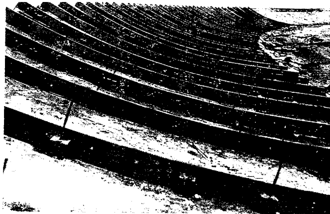
Установка опалубки на виражах для устройства армобетона
