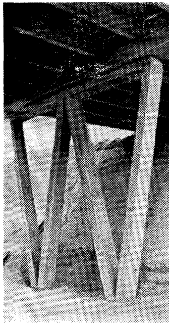
Рис. 3. Фрагмент опоры путепровода
